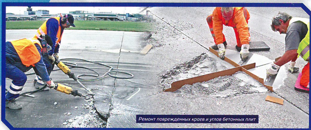
Ремонт бетонных компенсаторы
