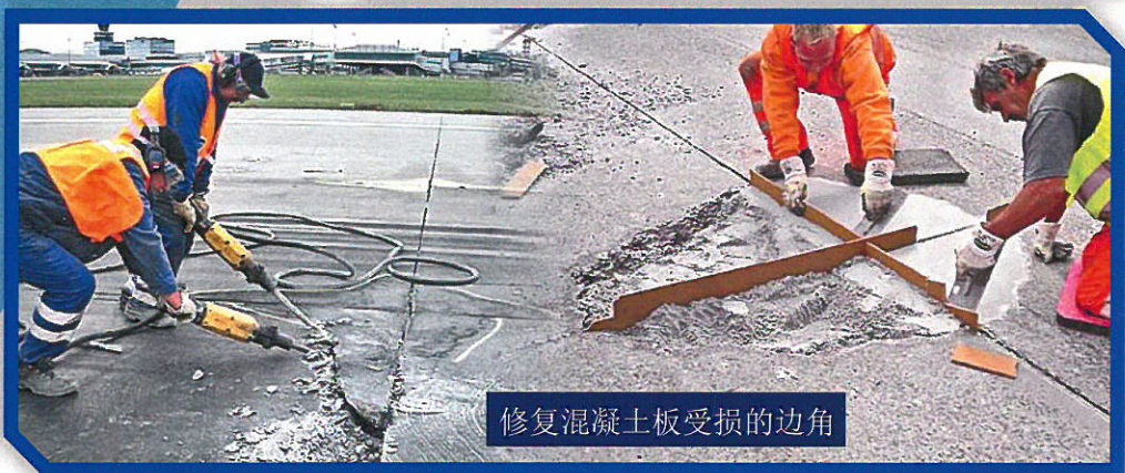
修复混凝土伸缩缝
